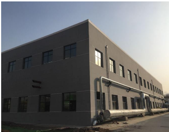
Figure 8：能源首站外观图
