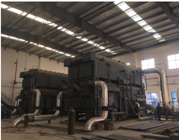
Figure 9：能源首站内的两台热泵
