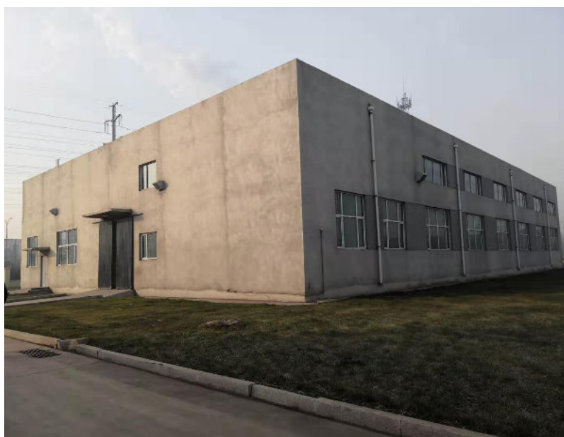
Figure 4 金投热力换热首站外观图
